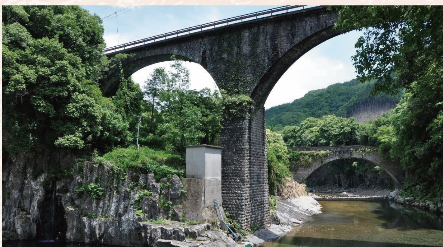
▲石橋アーチ径間日本一と二位が並ぶ風景(手前が轟橋 奥は出合橋)
