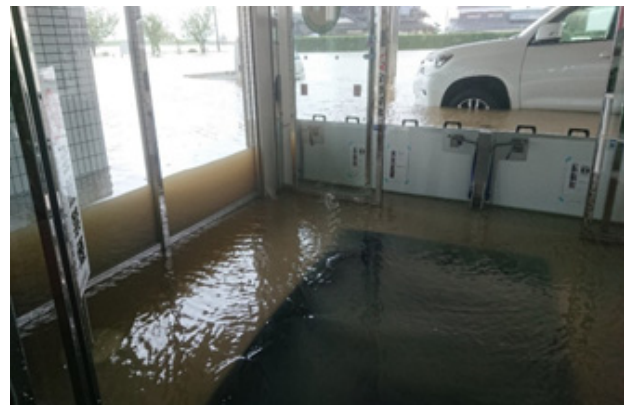
写真-5 止水板を設置した玄関
