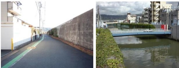
写真-5 寝屋川の河川堤防(大東市住道付近)
