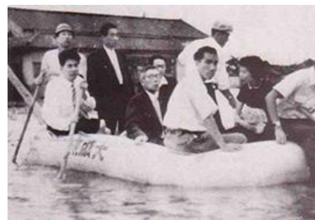
写真-2 昭和32年6月八尾実績降雨による浸水被害
