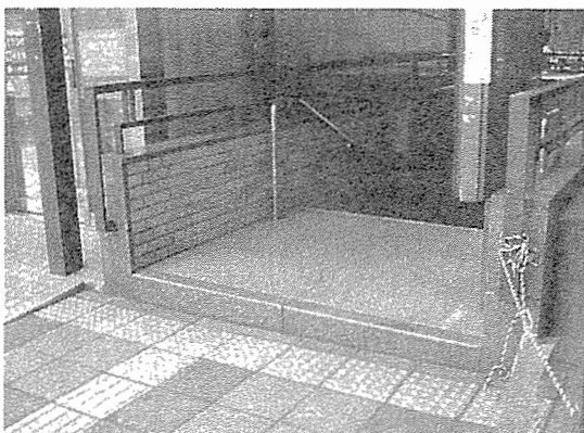
写真-2 地上部の階段入口に設けられた段差(ステップ)
