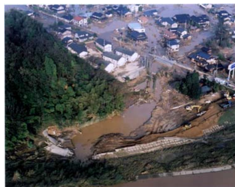
写真-3 出石川鳥居橋付近での破堤 (国土交通省 近畿地方整備局 提供)
