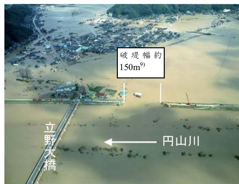
写真-2 円山川立野地先での破堤氾濫 (国土交通省 近畿地方整備局 提供)
