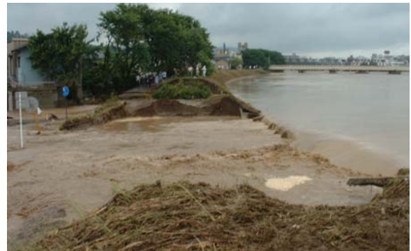
写真-1 足羽川左岸福井市春日1丁目付近での破堤の状況(2004年7月18日14:30頃) 4)
