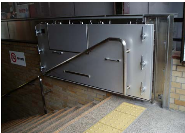
写真-4 止水板設置例（地下鉄博多駅出入口）
