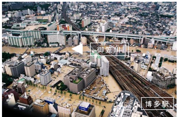
写真-2 博多駅東側の浸水状況 (H15.7.19)
