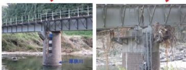
写真-14 洪水痕跡(図拡大)
