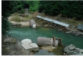
写真-18 本郷地区JR美祢線被災橋梁 (右写真提供：宇都日報社)
