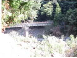
写真-17 被災橋梁下流の橋梁
