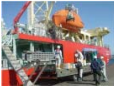
クレーンによる支援物資荷卸し状況
