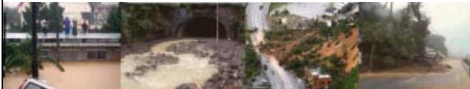
奄美市住用 総合支所
