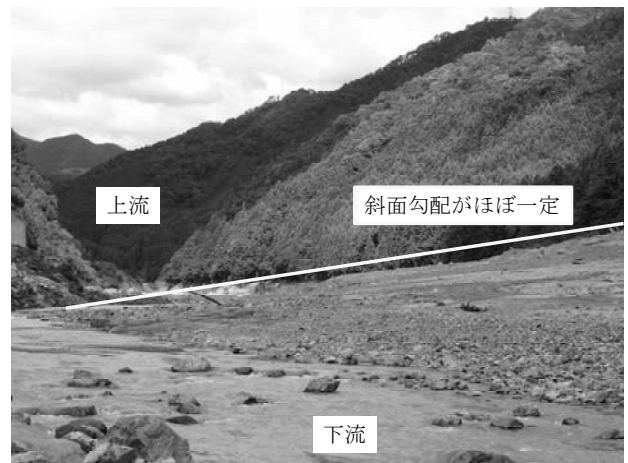
図-4 十津川町野尻における被災状況 伊半島の広い範囲で1000mmを超え、奈良県上北山村にある国土交通省の雨量計では、降り始めの8月30日から9月5日までの総雨量が2439mmとなっており、記録的な大雨となった。
