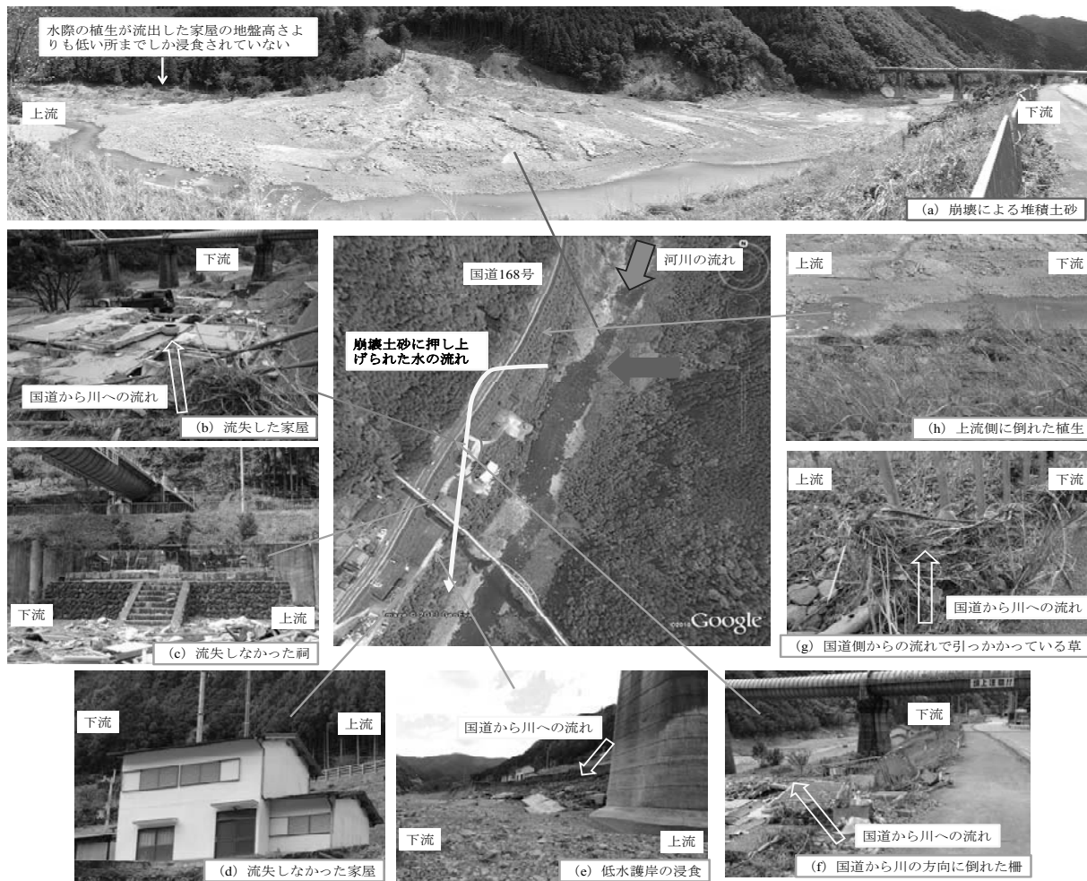
図-3 十津川村野尻における被災状況
