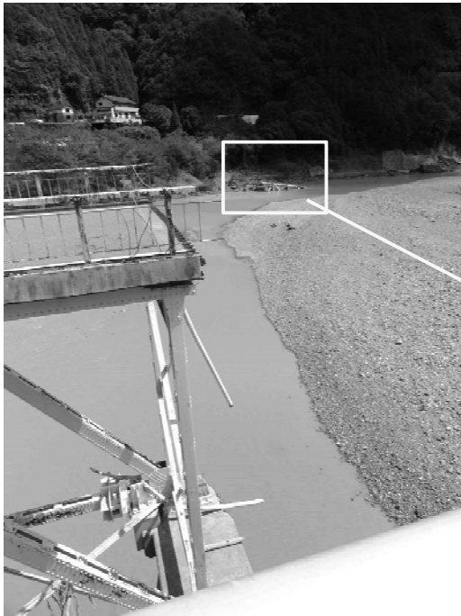
図-14 流失したトラス部分
