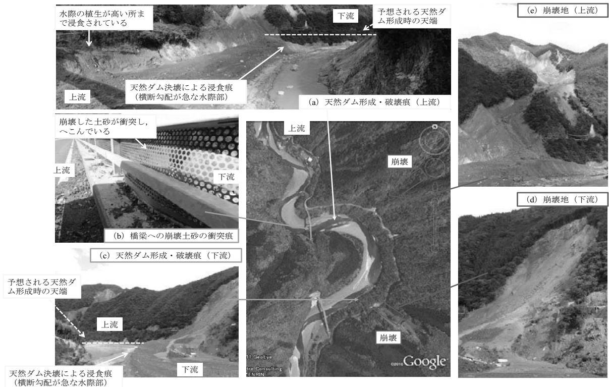
図-7 十津川村宇宮原における天然ダムの形成・破壊痕
