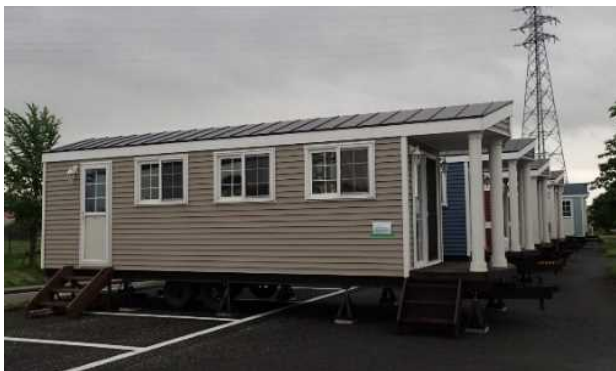
写真-1 トレーラーハウスを利用した福祉避難所
