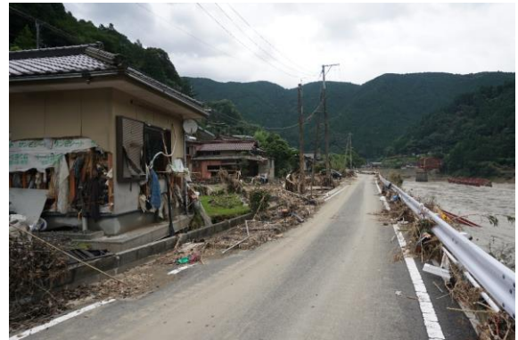
写真-5 本川沿いの坂本町下鎌瀬の様子 (7/13)
