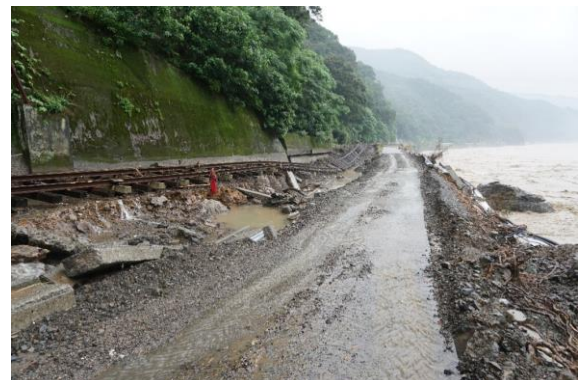
写真-4 球磨川沿いの県道158号とJR肥薩線の崩壊 (7/11)
