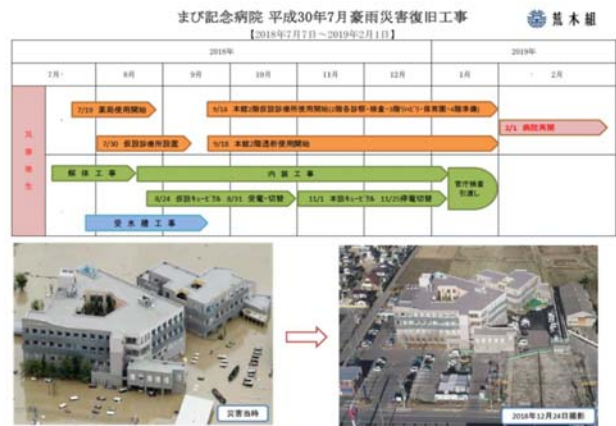
図-8 復旧工事の工程表（建築会社荒木組提供）
