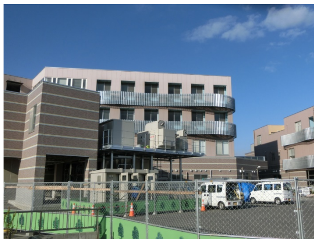
写真-7 キュービクルの高所への移設
