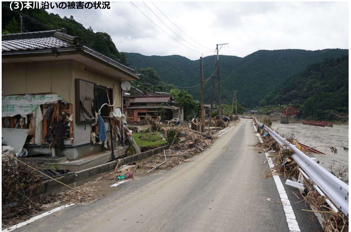
写真- 5 本川沿いの坂本町下鎌瀬の様子 (7/13撮影) 逃げる準備をしている間にも水が上がってきた
