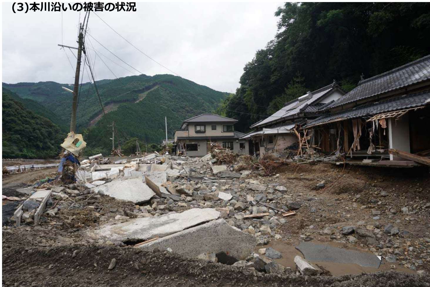
本川沿いの下鎌瀬の様子（7/13撮影） 強い流れにより基礎ごと家屋が流失している
