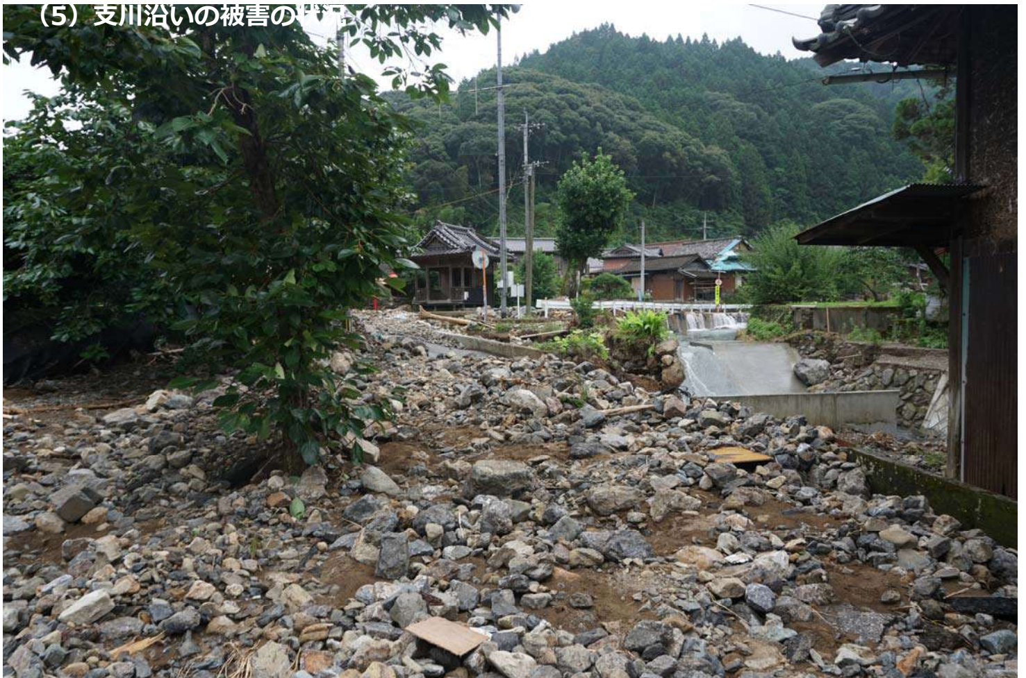
写真- 8 岩石礫によって閉塞した支々川の陣之内川（7/13撮影） 支々川沿いの道路に岩、石、礫が堆積
