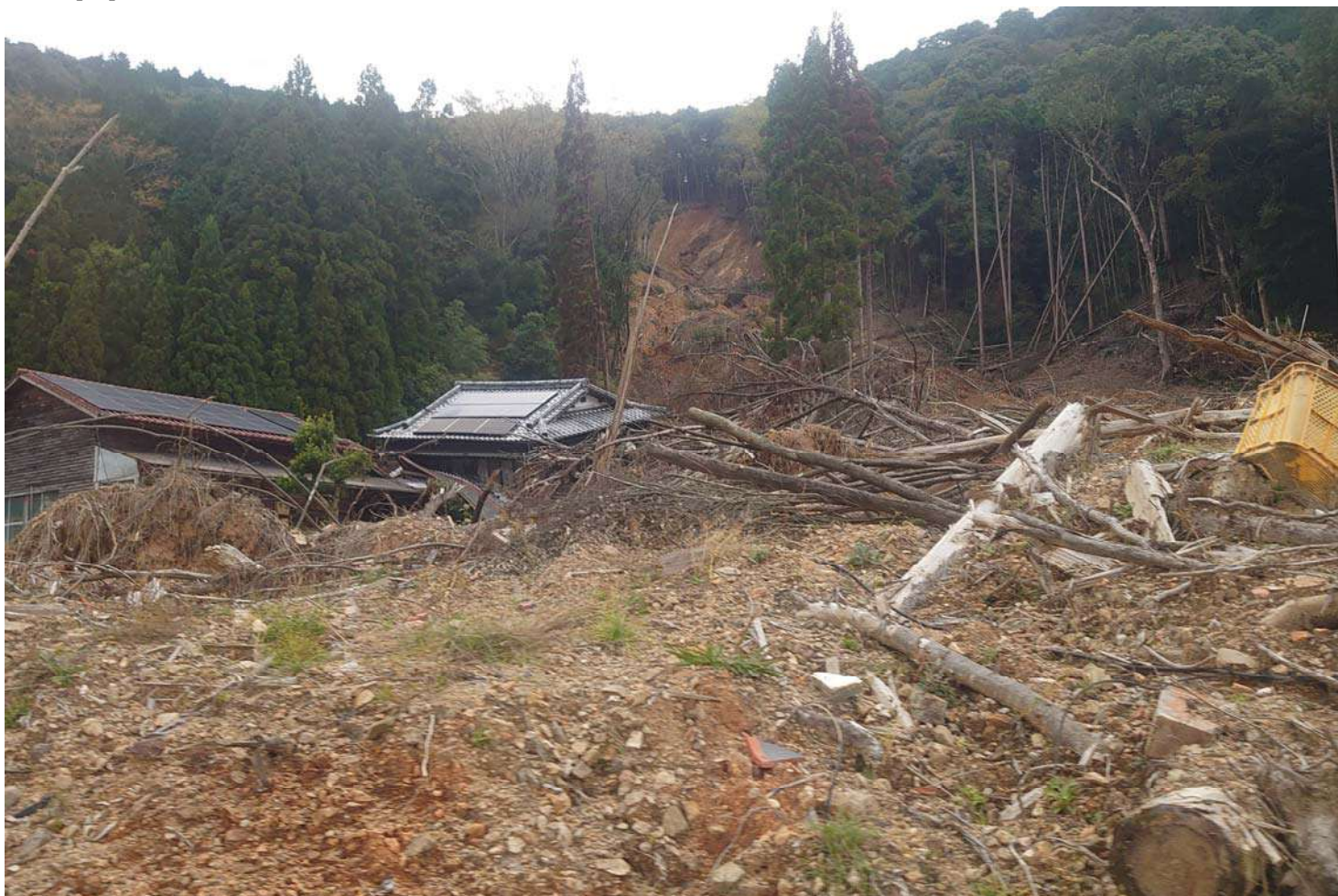
写真- 3 芦北町田川地区の斜面崩壊の様子（11/27撮影） 風化した砂岩が山頂付近から崩壊
