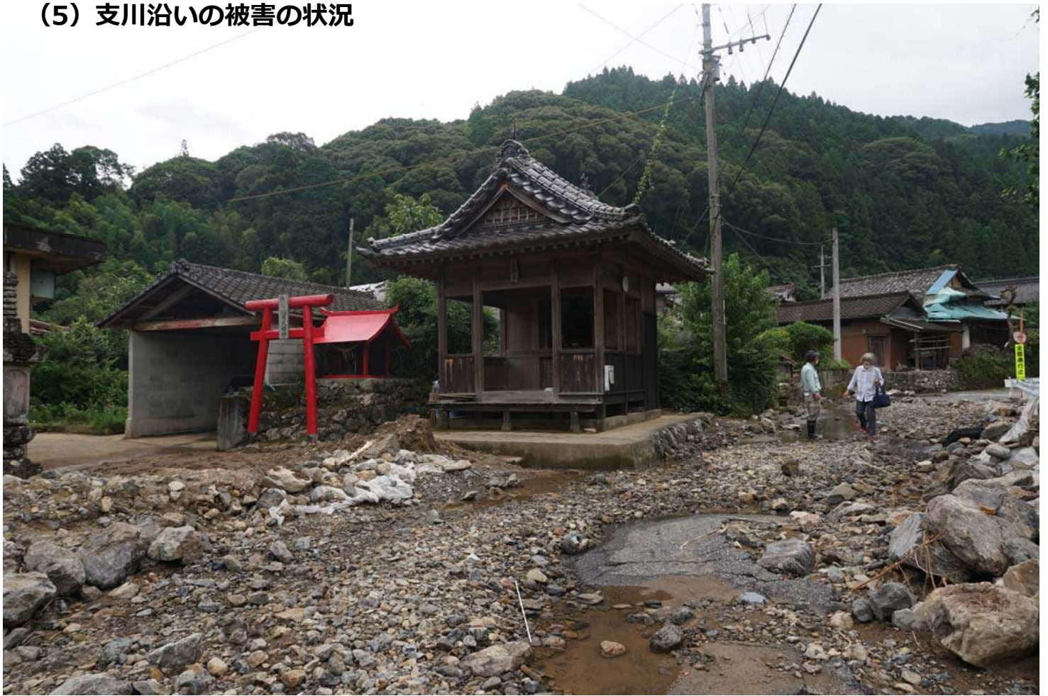
写真- 8 岩石礫によって閉塞した支々川の陣之内川（7/13撮影） 支々川沿いの道路に岩、石、礫が堆積
