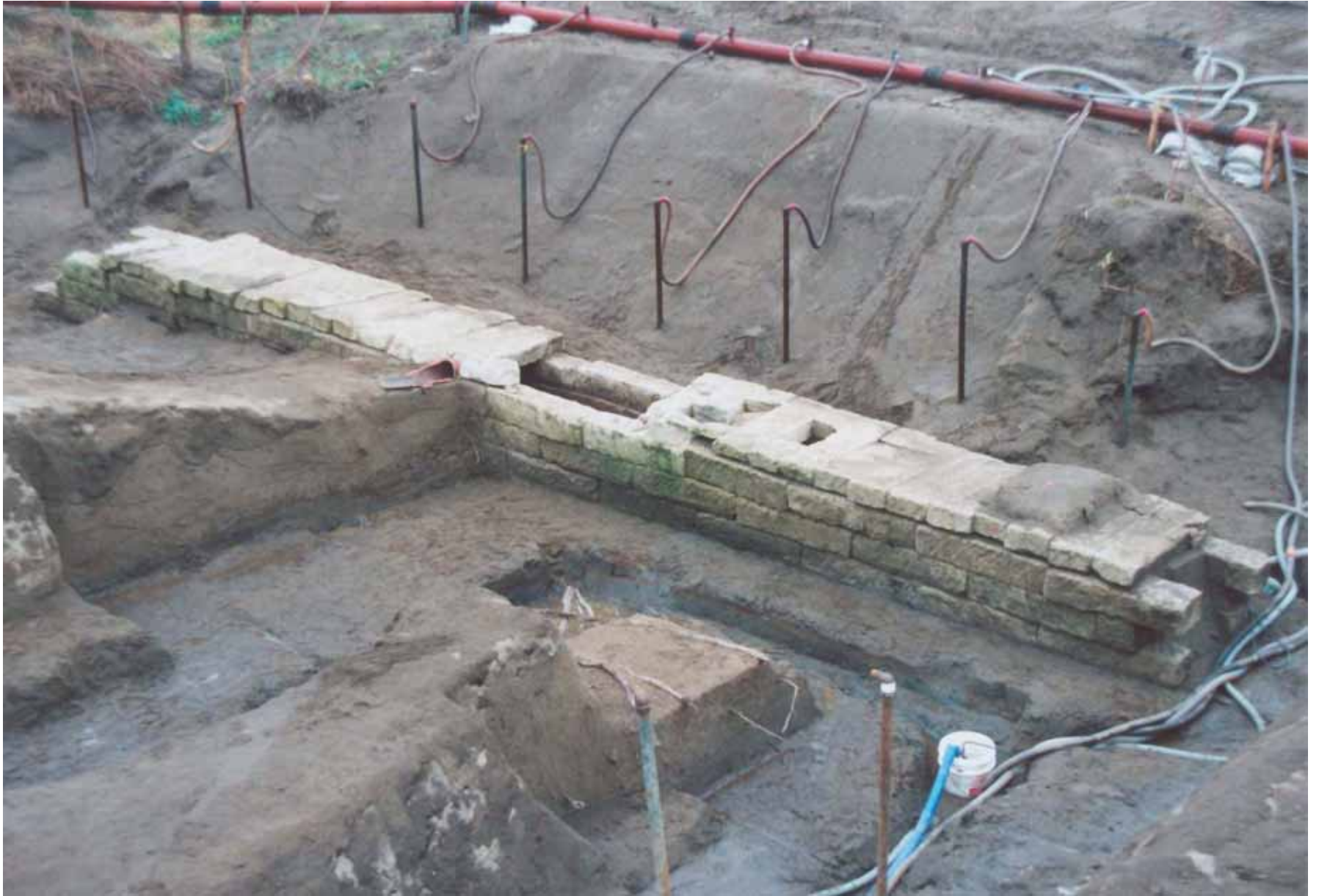
悪水吐暗渠発掘全景
