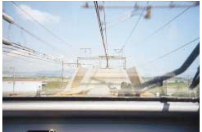
車内の観測ドームからパンタグラフの様子が確認できる
