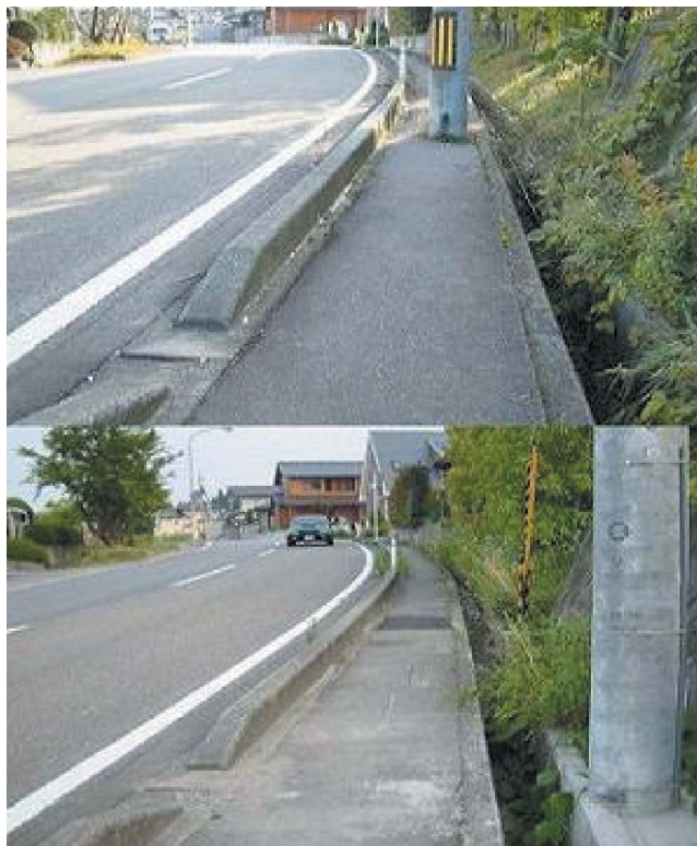
モニターの意見によって移動された歩道の電柱 (写真上：移動前、写真下：移動後)
