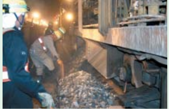
ホッパー車による碎石詰込み作業の様子（2:00）
