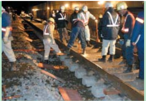
新幹線の道床更換工事の様子
