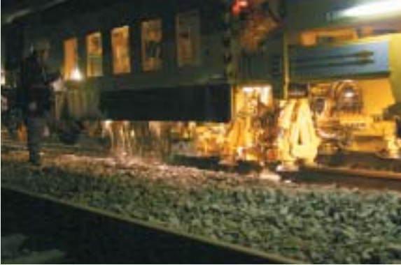
マルチプラタイタンバーによる振動締固めの様子(2:30)
