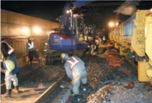
小型バックホーによる碎石回収の様子（0:30頃）
