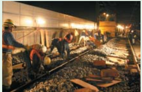
人の手により碎石が均される様子（2:15頃）
