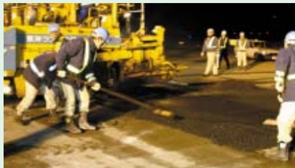
敷均しの様子
