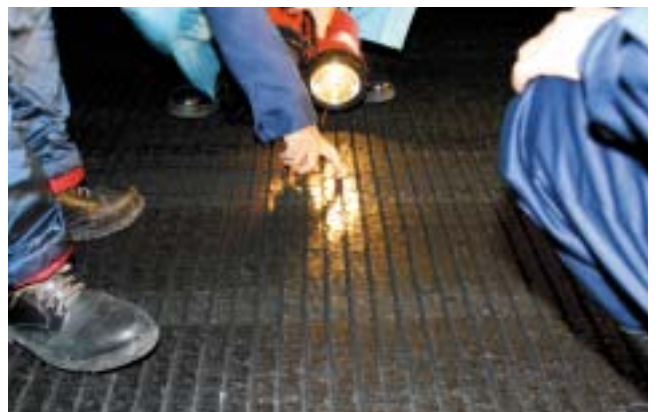
滑走路表面には32 mm間隔で、深さ6 mm、幅6 mmの溝がある。飛行機が着陸すると、この溝にタイヤのゴムが付着する。ゴムの撤去はウォータージェット噴射により定期的に行われている。
