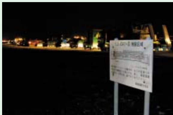
工事車両が制限区域に進入する様子。制限区域前には看板が掲げられている。一列に並ぶ工事車両の隊列に頼もしさを覚える。
