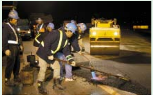
コンバインドローラにより転圧している様子
