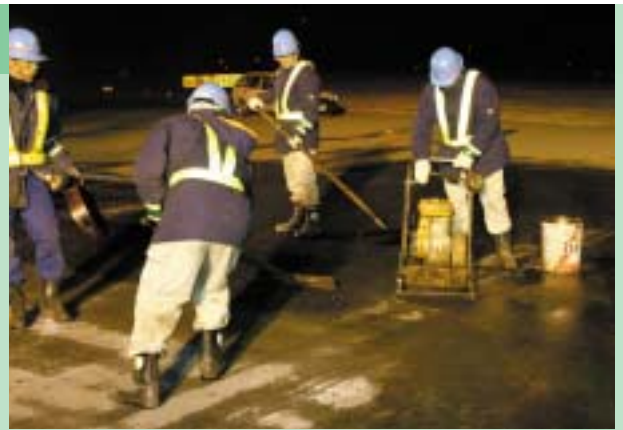
誘導路切削削換工事の様子
