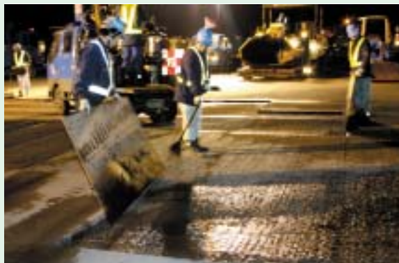
乳剤散布の様子。付帯構造物を汚さないように慎重に行われる。
