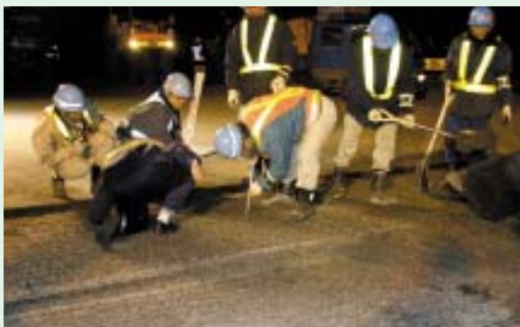
切削深さを深さを入念にチェックしている様子。厳しく施工管理されていることが窺える。
