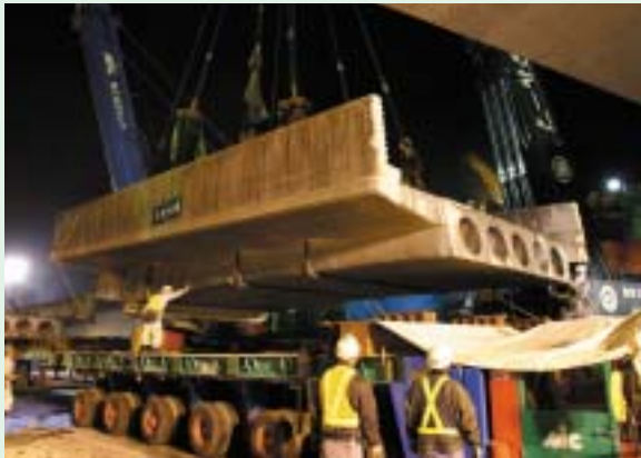
切断された跨道橋を移動式台車で運ぶ様子(2:00頃)
