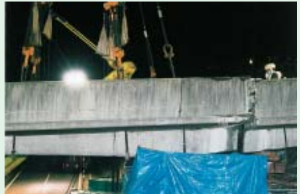
跨道橋の1ブロックを切断する様子(1:00頃)
