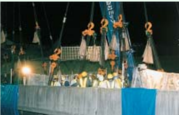
玉掛け作業の様子(23:30頃)
