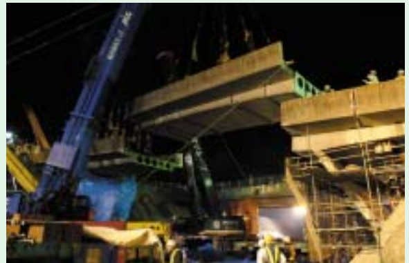
切断された跨道橋の1ブロックをクレーンで運ぶ様子(1:00頃)
