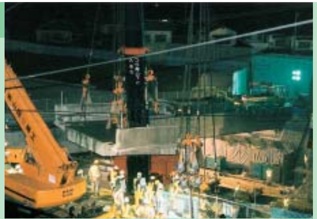
跨道橋の撤去工事の様子
