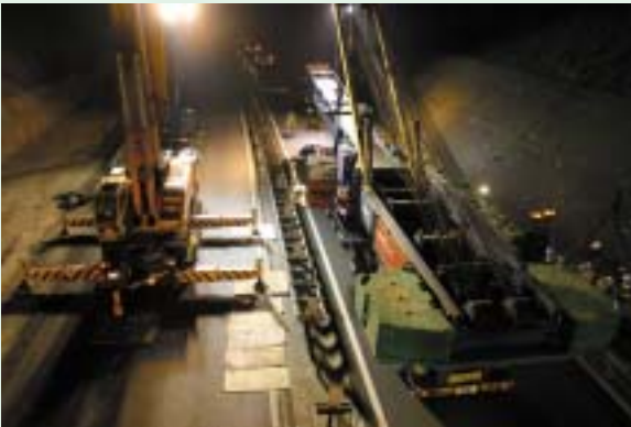
800tクレーンにカウンターウェイトを取り付ける様子(23:00頃)
