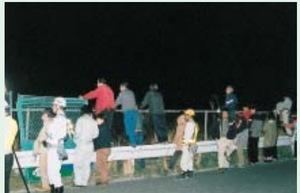
現場を見学する周辺住民の方々(1:00頃)
