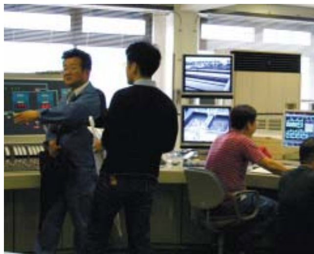
写真5 ポンプ管理室内でのインタビュー（左が岡田氏）。画面にはポンプの出力状況やアメダスや京都市内に配置される水位計の情報が表示され，これらの情報を基にポンプの出力が決定される
