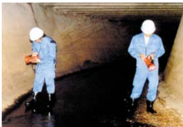
写真-1 管渠内を点検している様子 (京都市上下水道局パンフレットより)
