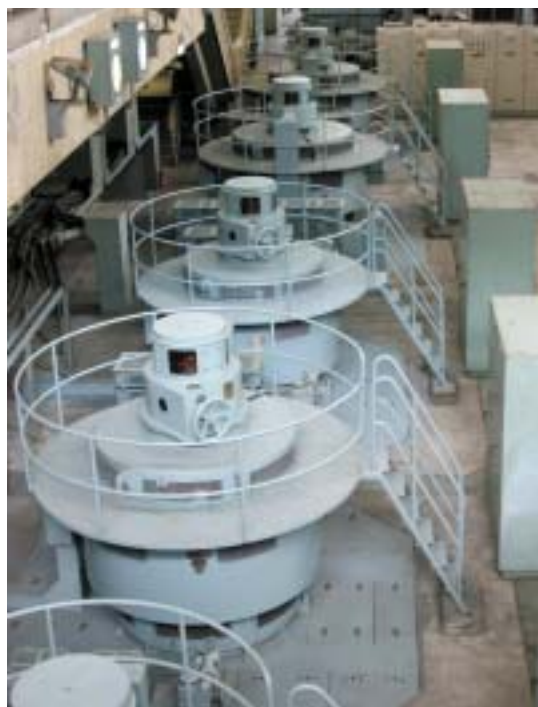
写真4 取水ポンプ（時々刻々と変化する流入量や水質に合わせて，24時間運転管理される）
