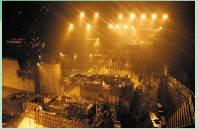
写真-1 ダム工事現場全体
