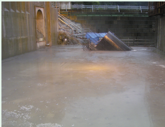
写真-10 コンクリート打設終了後の養生
