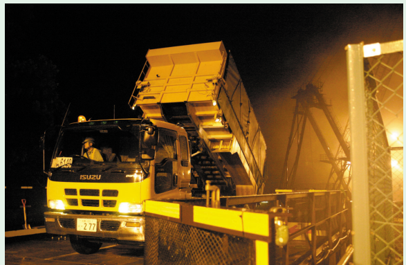
写真-6 ダンプトラックからコンクリートを移す作業
