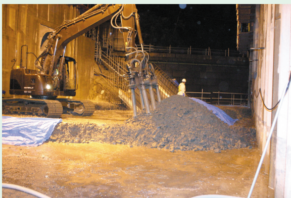
写真-9 バイバックによる締固め
