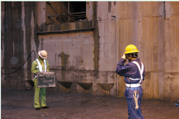
写真-3 作業前の最終点検
