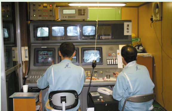
写真-4 機械制御によるコンクリートの製造
