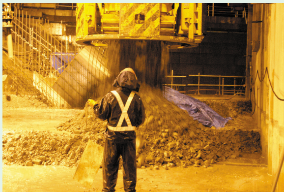
写真-8 バケットから排出されるコンクリート
