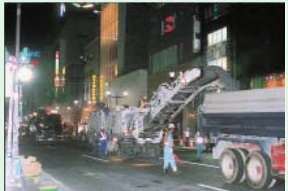
写真-4 路面切削作業・銀座6丁目付近(22:30頃)
