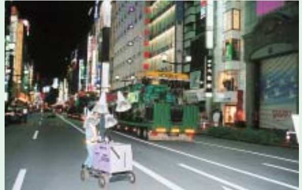
写真-3 工事車両の到着(21:15頃)
