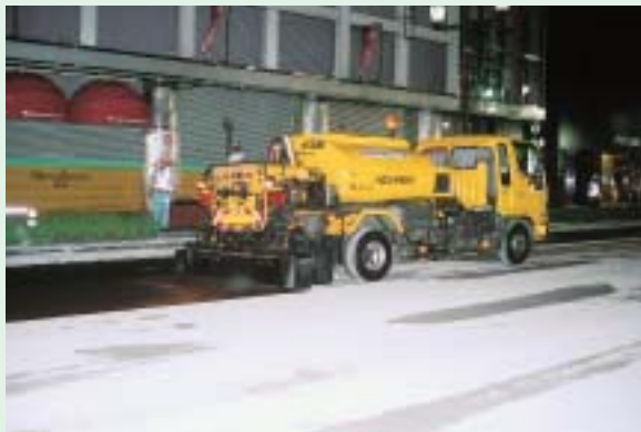
写真-6 アスファルト乳剤の散布(23:30頃)
