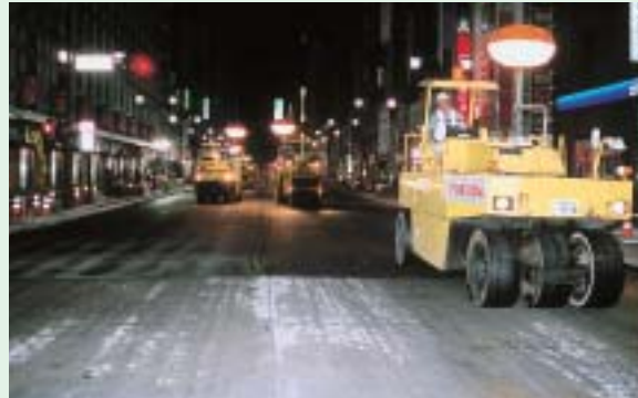
写真-8 ローラ作業(03:00頃)
