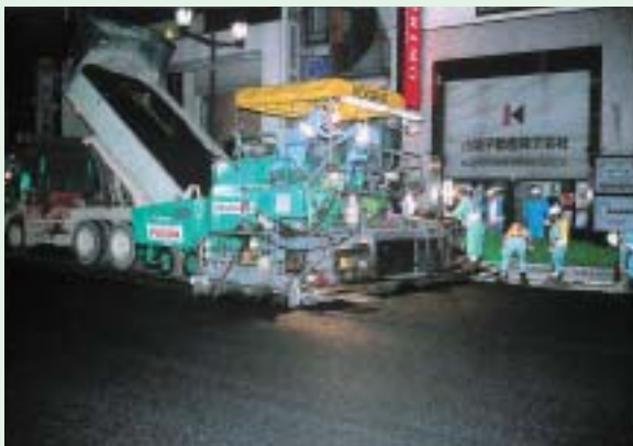
写真-7 アスファルトフィニッシャーによる作業・銀座5丁目付近(02:30頃)
