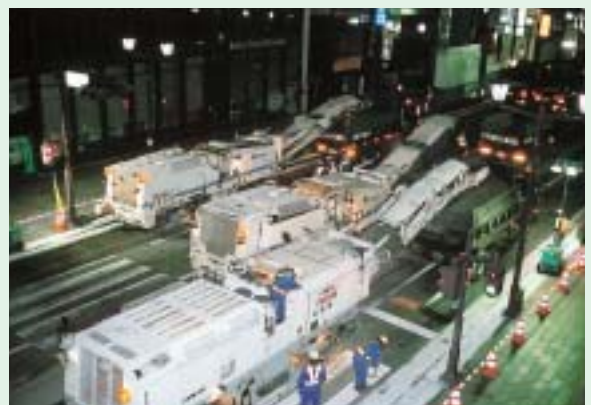
写真-5 路面切削作業・銀座7丁目付近(00:30頃)
