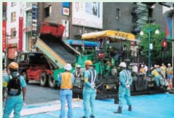
写真-9 アスファルトフィニッシャーによる作業(06:30頃)
