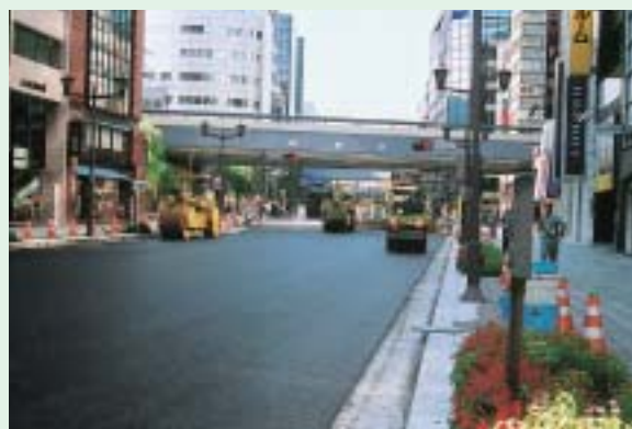
写真-10 ローラ作業(08:00頃)
