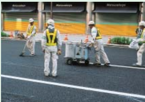
写真-11 区画線設置作業(08:30頃)
