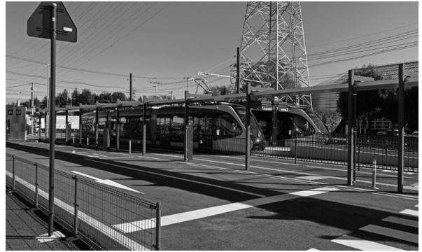
写真3 LRT (奥) とバス (手前) の停留所
