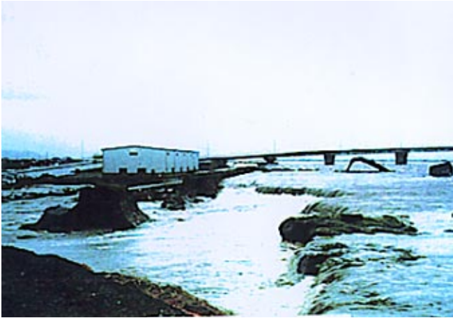
写真-7 氷川の氾濫状況
