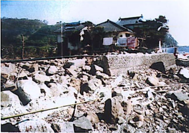
写真-1 永尾地区の被災状況
