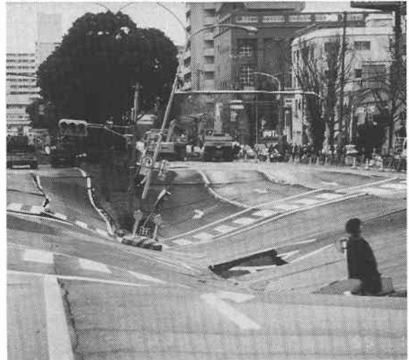
写真－16：大開駅直上の路面陥没
