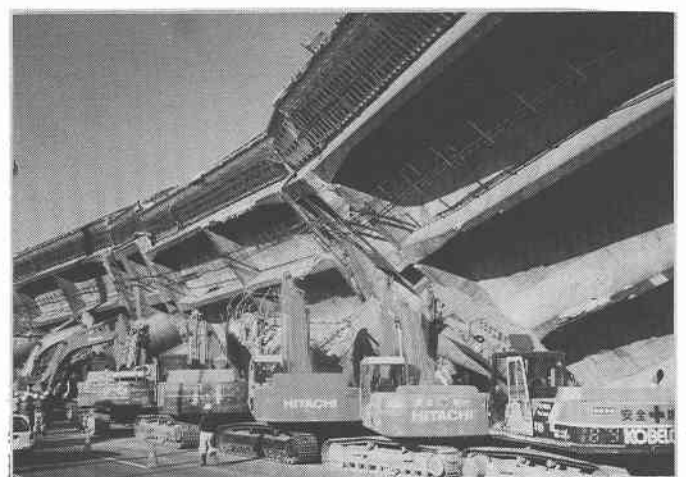
写真-4 ピルツ形式RC橋梁の倒壊（神戸線 深江地区）
