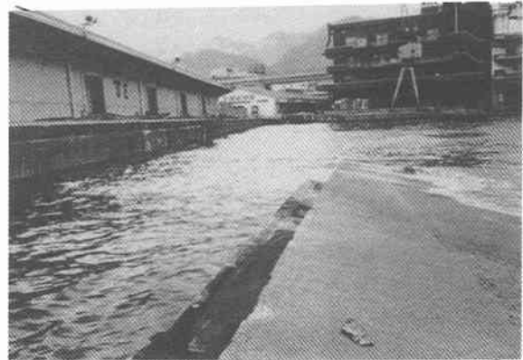
写真6 第1突堤東岸壁
