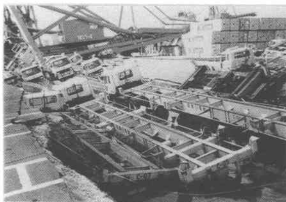
写真7 ヤード陥没によるクレーンの倒壊
