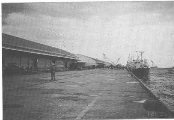
写真5 生き残った耐震バース (第1突堤西岸壁)
