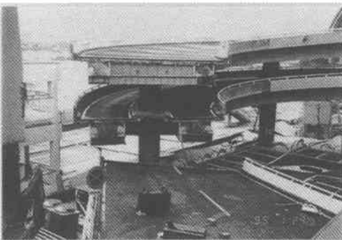
写真14 神戸大橋へのループ橋の落下
