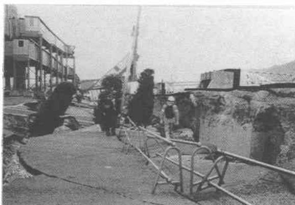
写真8 陥没したフェリーターミナル
