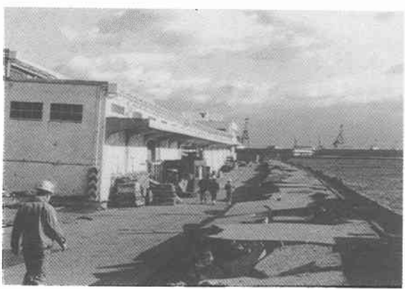
写真3 新港第6突堤西岸壁
