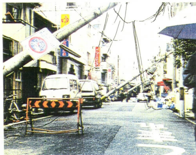
図11 電柱の倒壊による街路閉塞の例
