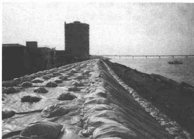
写真5.3.1 第一次緊急復旧工事
