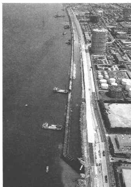
写真5.3.2 第二次緊急復旧工事
