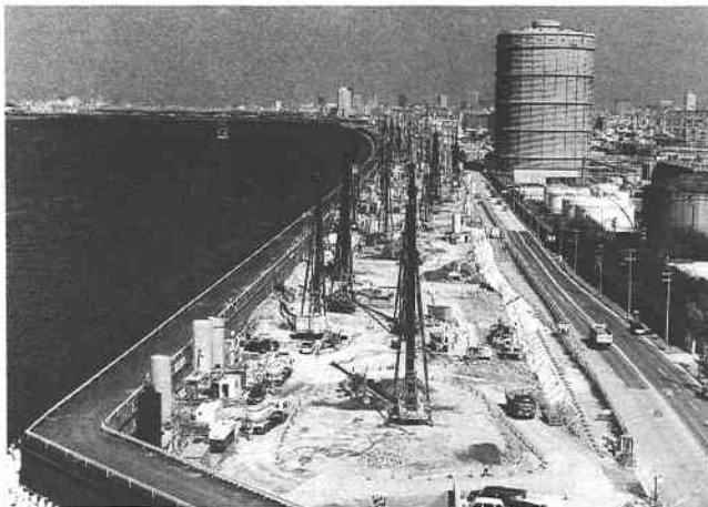
写真5.4.1 地盤改良施工状況
