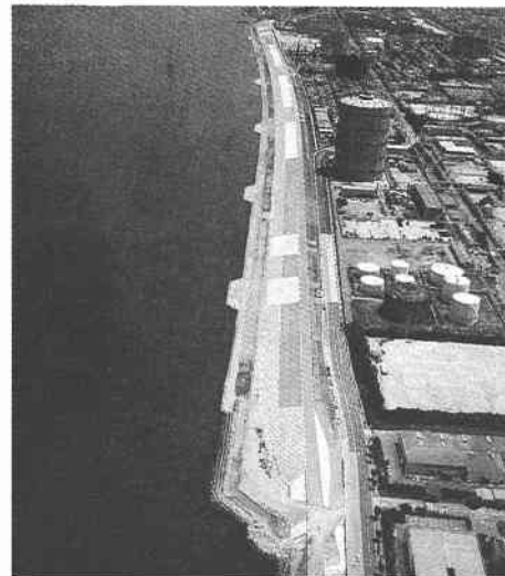
写真5.4.2 完成した西島堤防
