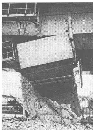
図-4.3.7 せん断破壊 9)
