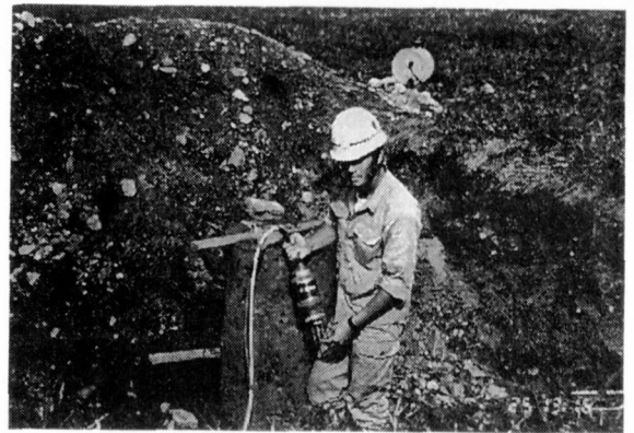
写真-5 杭内部のカメラ撮影
