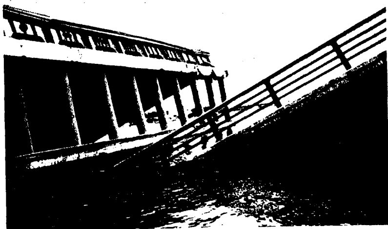
写真5.2 昭和39年新潟地震による昭和大橋の落橋
