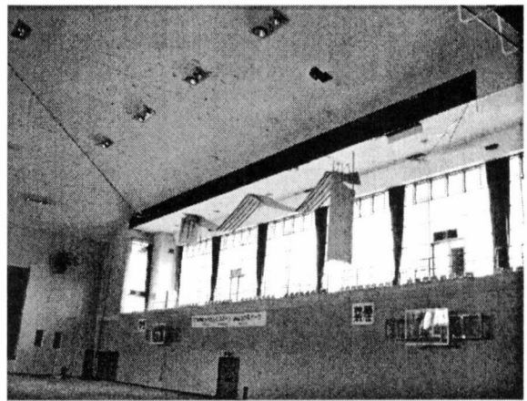
写真8 体育館の天井材(石膏ボード)の落下 (日本建築学会東北支部災害調査委員会)
