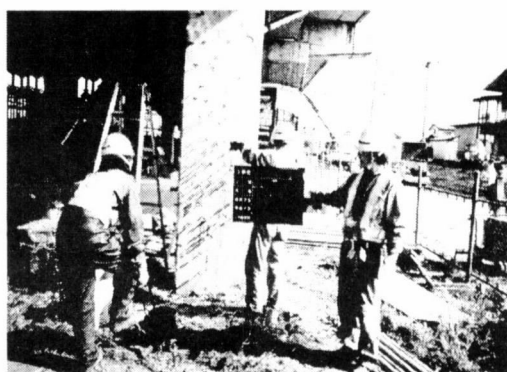
写真-10 ひび割れ注入状況
