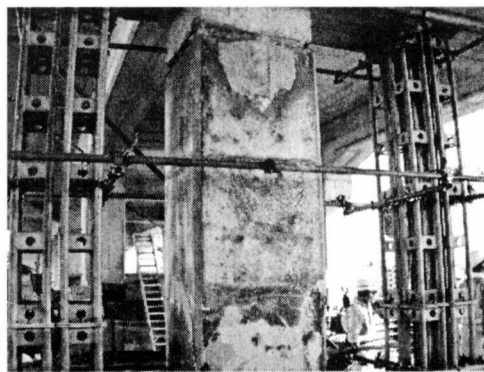
写真-12 断面修復後の状況
