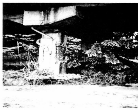
写真-4 第二中野の損傷状況
