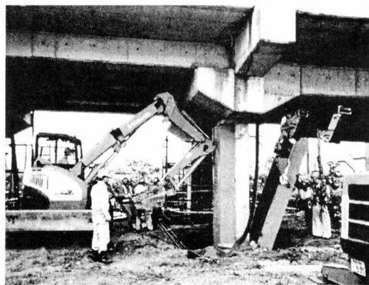
写真-14 鋼板巻き補強施工状況
