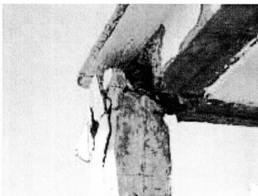
写真9 接合部の破壊
