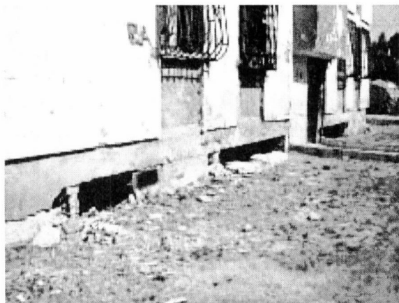
写真19 半地下の設備階を有する建物
