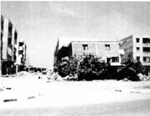
写真3 完全に崩壊した建物
