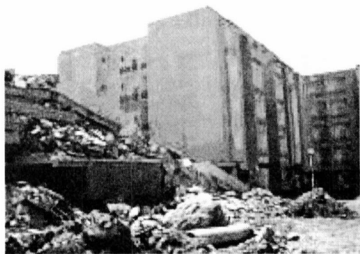
写真15 崩壊した建物と残った建物
