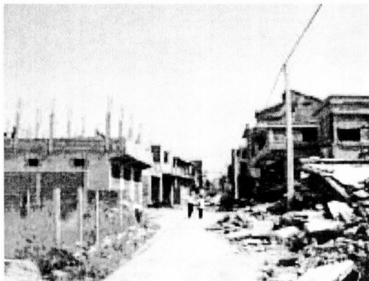
写真13 比較的新しい住宅の被害
