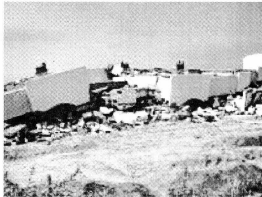
写真4 完全に崩壊した建物
