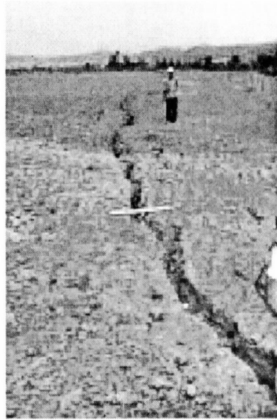
写真6 地表の地割れ（縦断方向）
