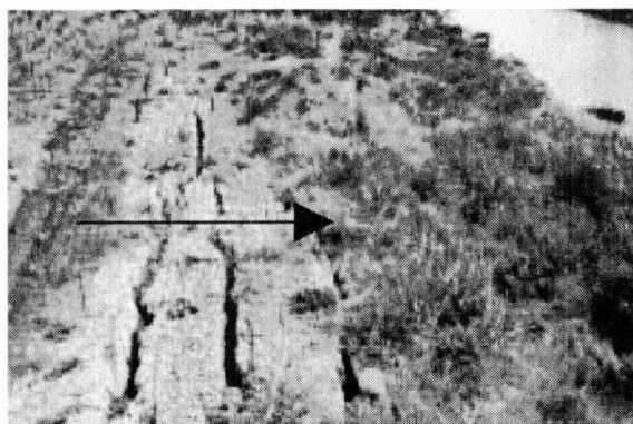
写真3 地盤の側方流動
