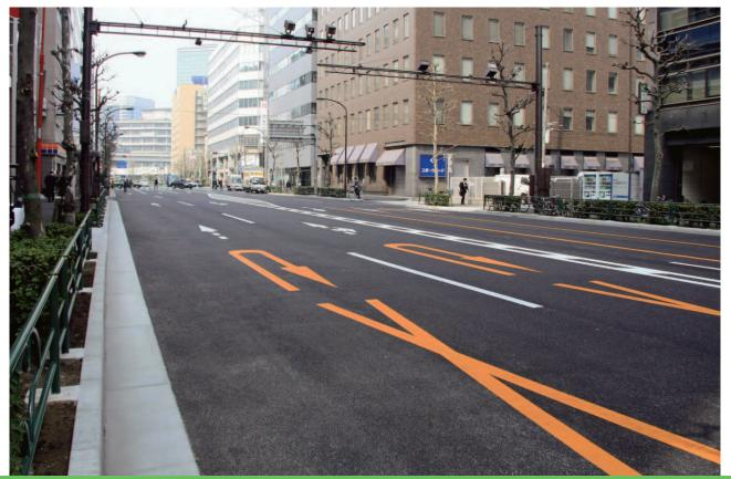
(業績・プロジェクト名) 浄水場発生土を使用した保水性舗装の開発および実証施工
